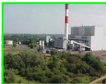
Centrale de Bouchain en exploitation
