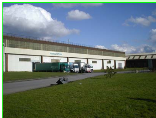
Quais de déchargement
