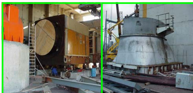
En cours de démontage
