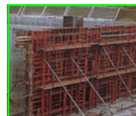
Coffrage poteau - Coffrage métallique à rayon variable
